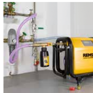
Dezinfekcia rozvodov pitnej vody
